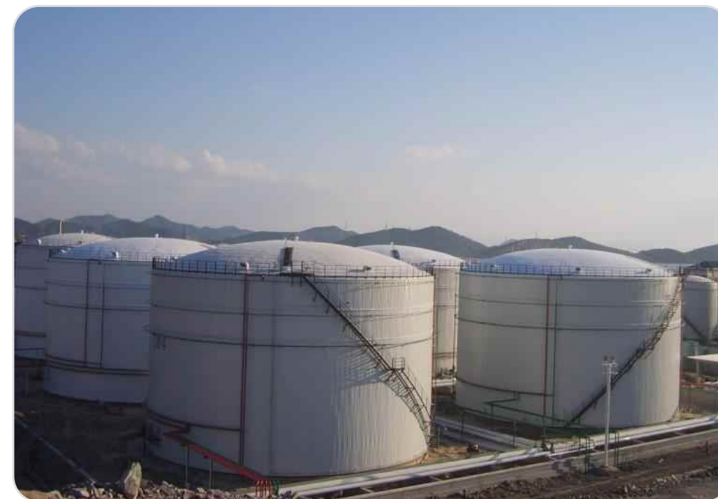
大型储罐 Silo
